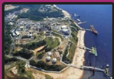
PETROBRAS Refinaria de Manaus - REMAN
